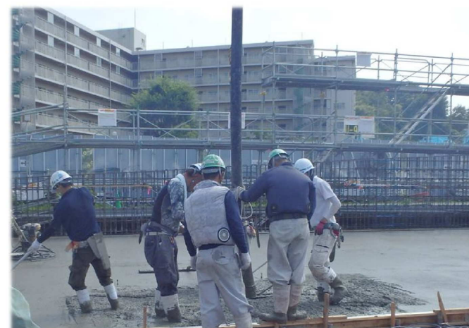
流動化処理土打設状況(イメージ)
