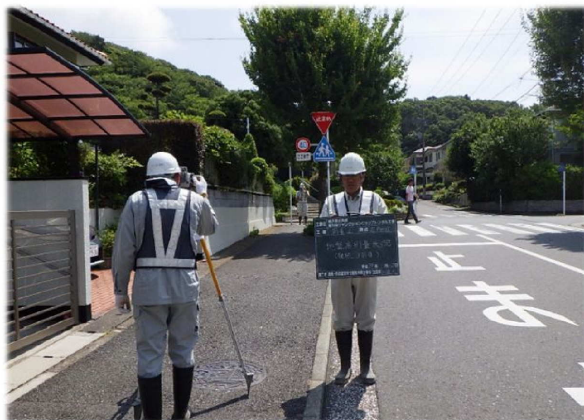
道路の高さ測量
