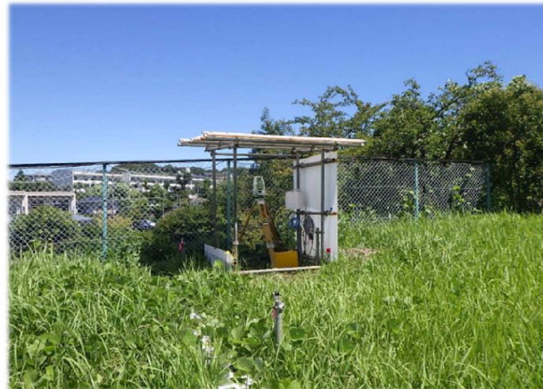
事業用地内の地表面の高さ測量
