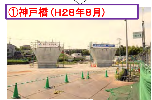
※橋梁下部工工事
