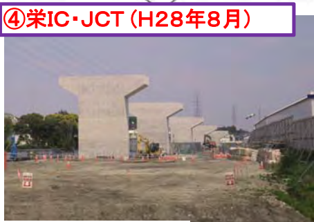
※橋梁下部工工事
