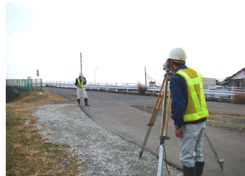
道路現況高さ測定・ 地表部の地表面沈下測量(イメージ)
