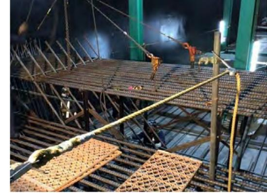
■埋設型枠の採用（低土被り区間）
