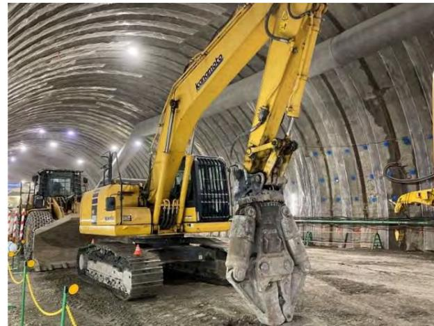
＜先進導坑（支保工・吹付コンクリート）撤去時＞
