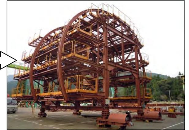
分合流区間は断面の大きさがパターン毎で異なるため、改造を施しながら大きく5つの区間に分けて、展張機付シート台車を使用。
