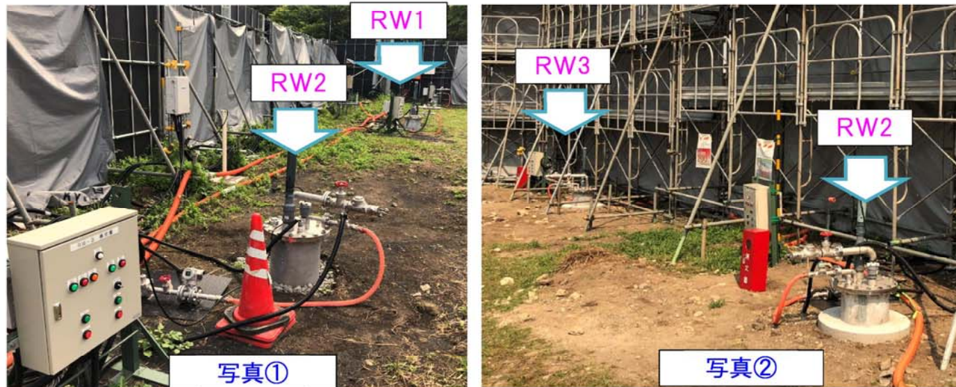
写真1: 注水井設置状況
