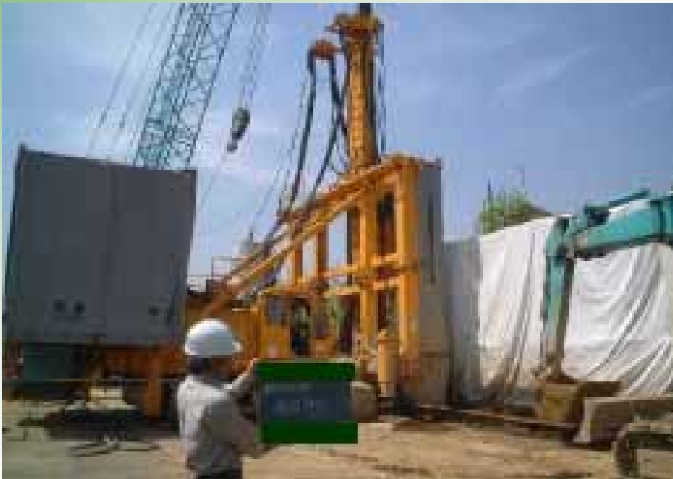
地下連続壁(土留め壁)施工
