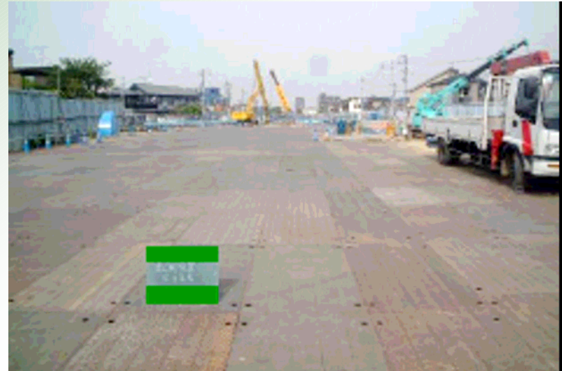
中間杭を建て込み後、路面覆工
