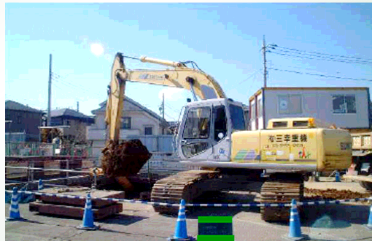
覆工板の下部に作業ヤードを確保
