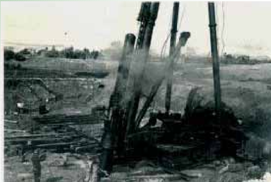
鋼管杭の打込み
