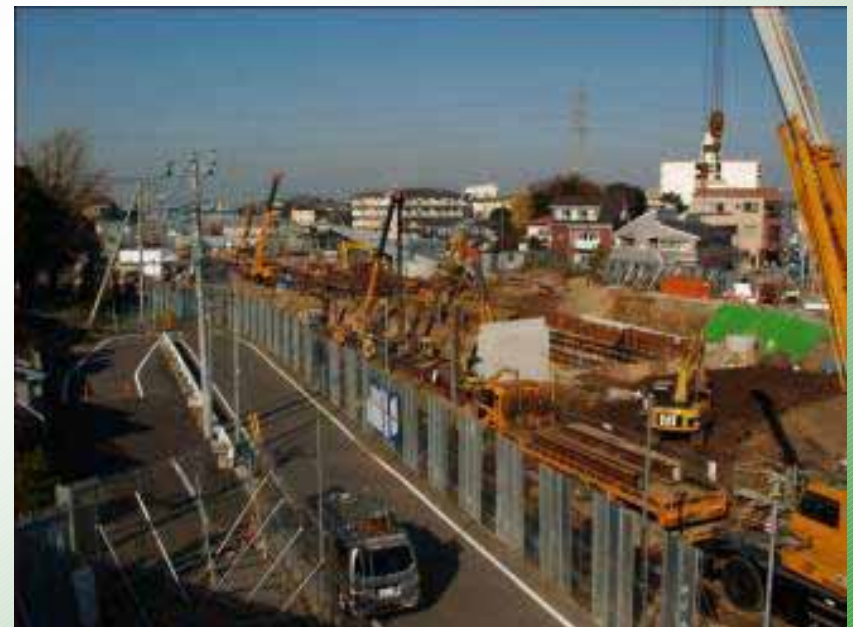
地下連続壁施工
