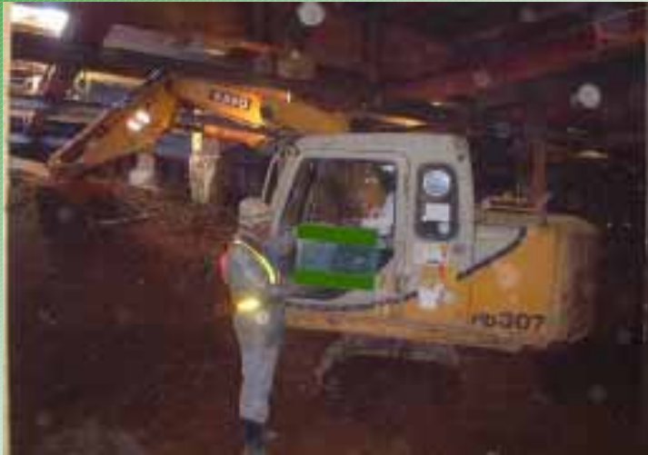
覆工板の下部で頂版下部まで掘削
