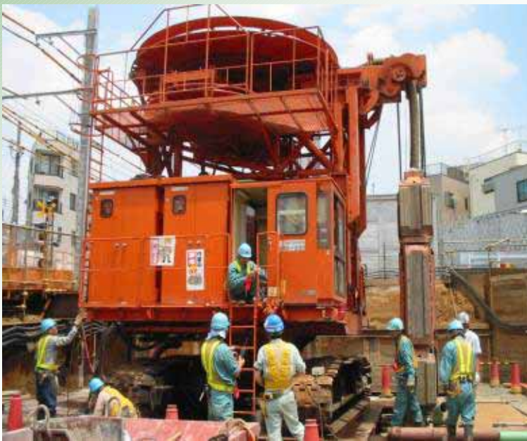
地下連続壁施工
