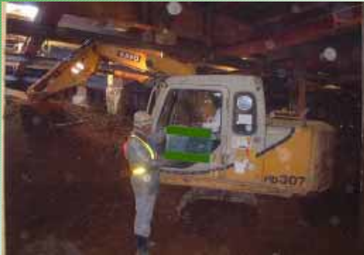
覆工板の下部で頂版下部まで掘削
