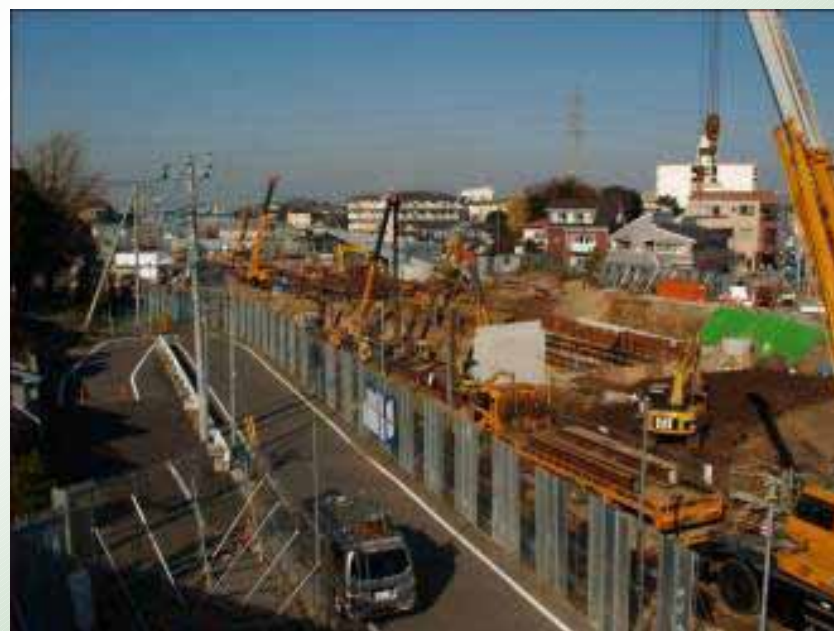
地下連続壁施工
