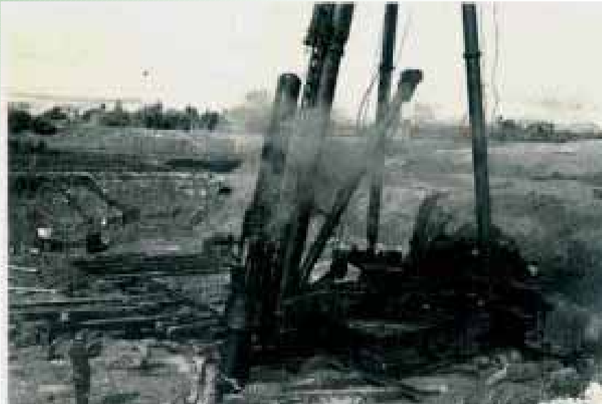
鋼管杭の打込み
