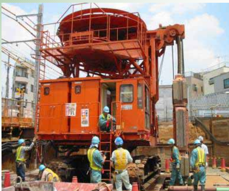
地下連続壁施工
