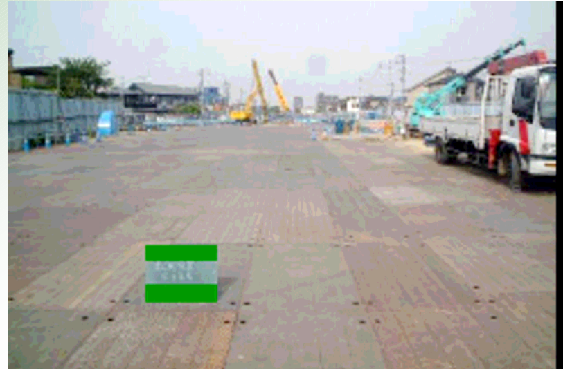
中間杭を建て込み後、路面覆工
