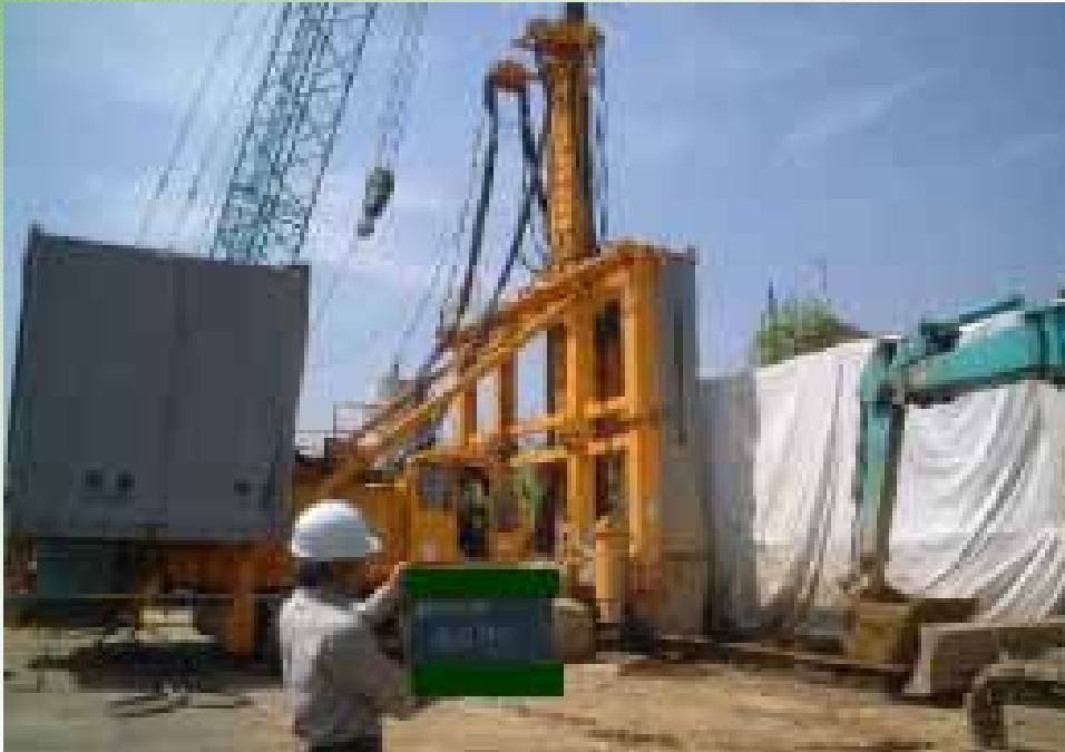
地下連続壁(土留め壁)施工
