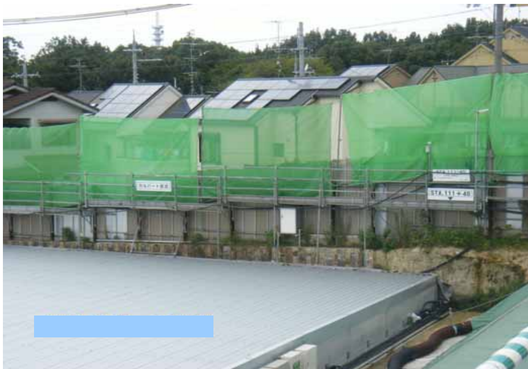
防音シェルターの施工例
