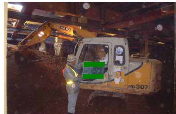
坂巻工法の施工例
