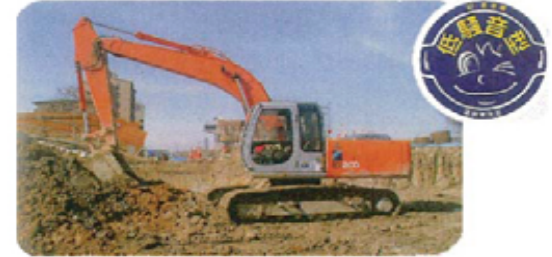
粉塵防止のための散水
