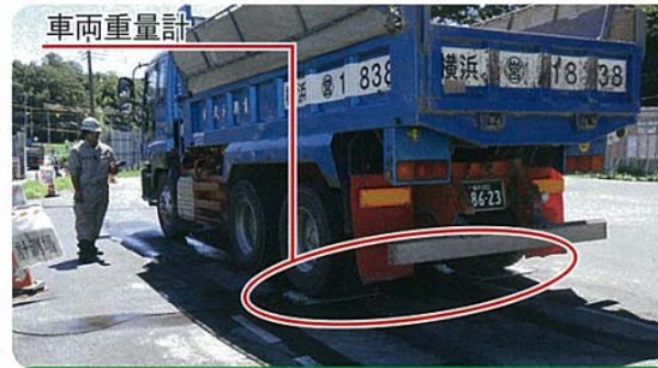
ダンプトラックに土を積み過ぎていないか計測しています。
