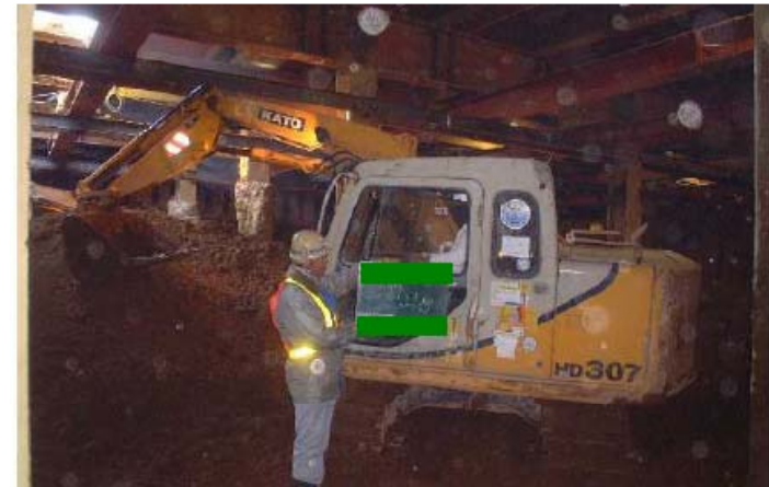
開削工法の施工例
