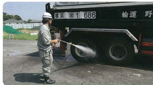
道路に土を落とさないように、タイヤを洗っています。
