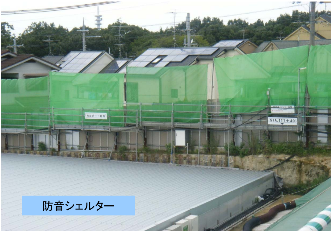
防音シェルターの施工例
