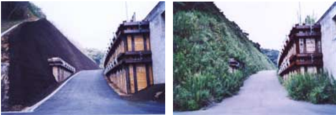
郷土種（ヤマハギ、イタドリ、ヨモギ、ススキ）によるのり面の緑化
