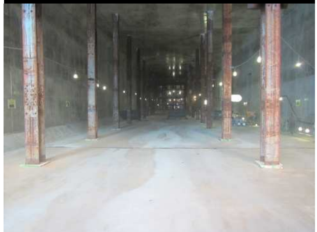
II ランプ工区 (Aランプ) 施工状況
