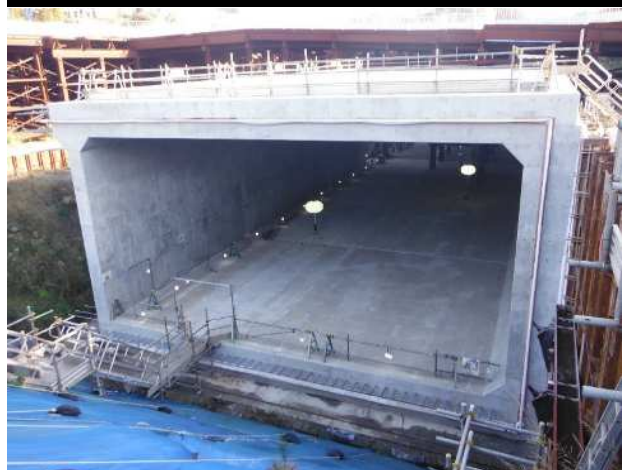
IV ランプ工区 (Dランプ) 施工状況
