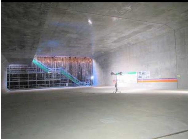
I 函渠工区 施工状況
