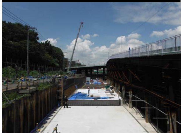
IV ランプ工区 (Dランプ) 底版コンクリート施工状況
