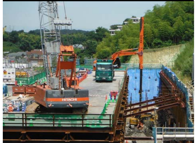
II ランプ工区 (Aランプ終点側) 掘削施工状況
