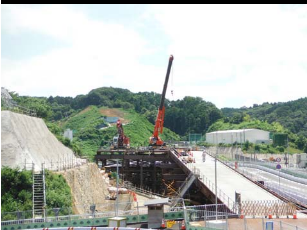
III ランプ工区 (Aランプ起点側) 仮設栈橋施工状況
