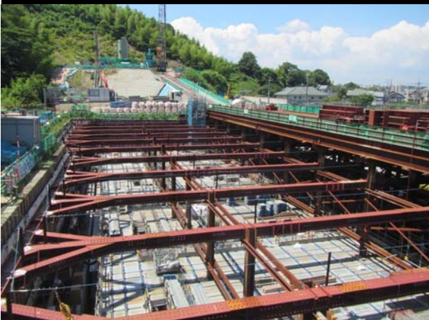
I 函渠工区 コンクリート施工状況
