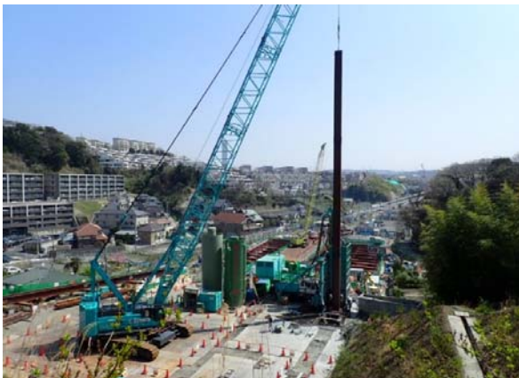
①写真：山留工（等厚式連続壁工）の施工状
