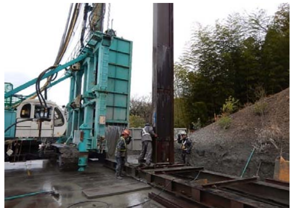
②写真：山留工（等厚式連続壁工）の施工
