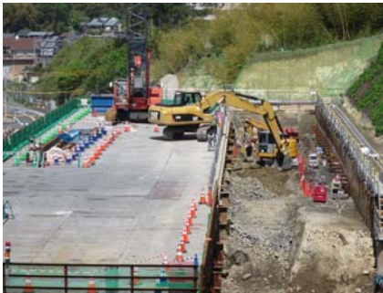
②写真：掘削作業の状況
