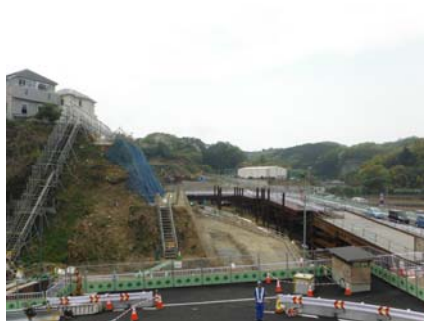
③写真：作業状況
