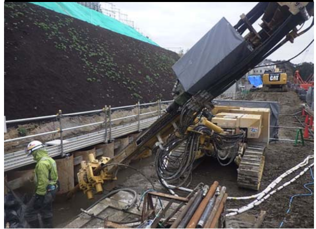
II ランプ工区 (Aランプ終点側) 土留工施工状況
