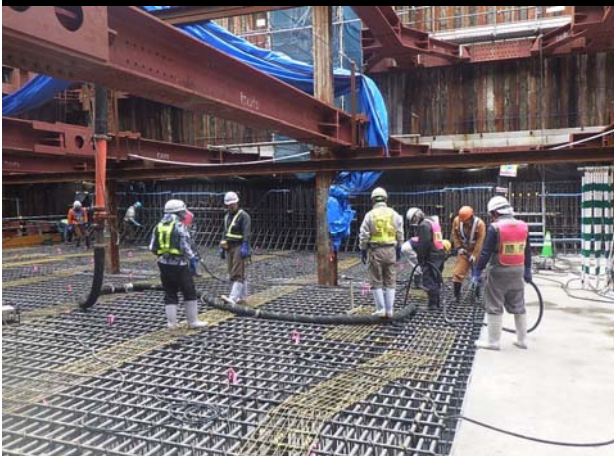
I 函渠工区 生コンクリート打設状況
