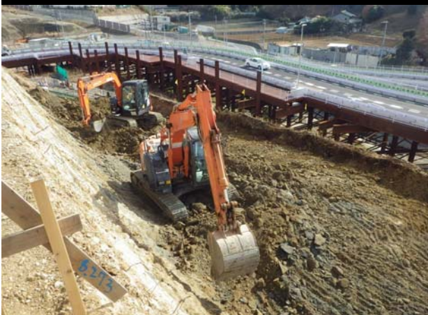
III ランプ工区 (Aランプ起点側) 切土施工状況
