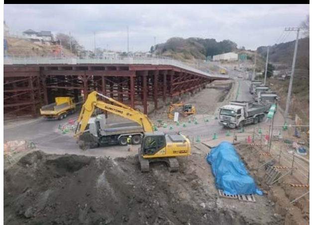
IV ランプ工区 (Dランプ) 掘削施工状況
