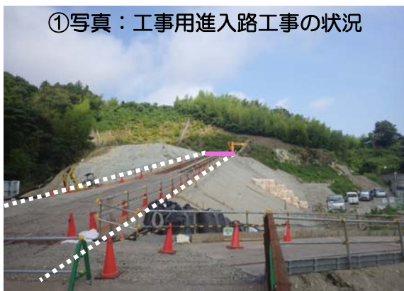
①写真：回転立坑作業ヤードまで登って行くための、工事用車両進入路を造る工事を行っています。
