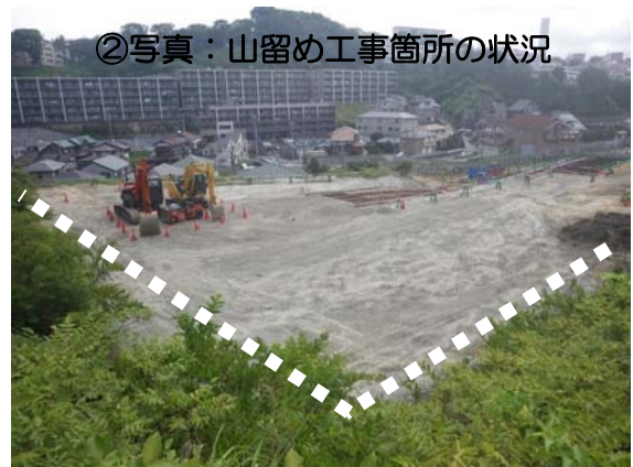
②写真：回転立坑作業ヤードにて掘削するための、山留め工事（等厚式連続壁）を行います。
