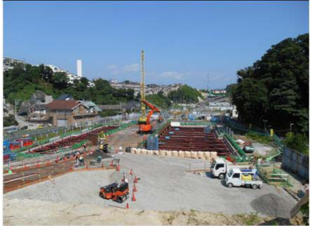
II 函渠工区 施工状況
