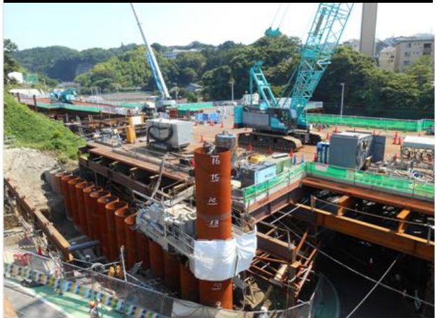
IV ランプ工区 Aランプ 土留工施工状況
