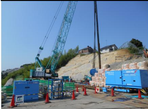
III ランプ工区 Aランプ 土留工施工状況
