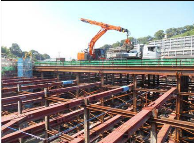
I 函渠工区 掘削状況
