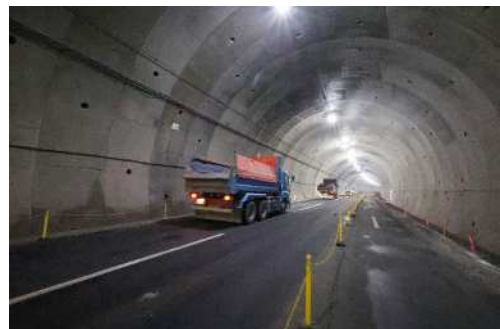
桂台トンネル内工事用道路状況
