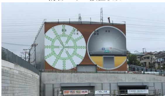
防音ハウス設置状況
