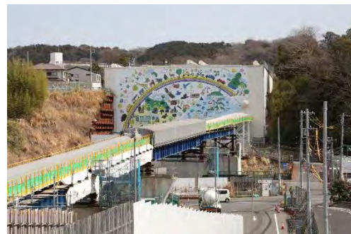
ベルトコンベア設置状況
