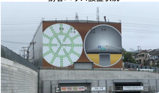
防音ハウス設置状況
