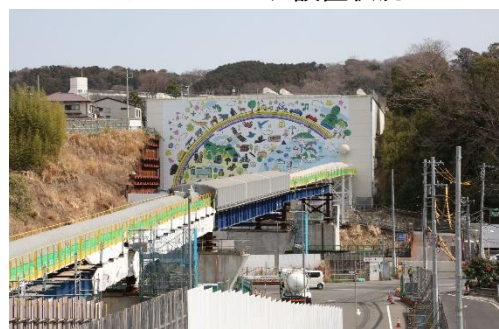
ベルトコンベア設置状況
