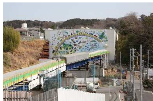
ベルトコンベア設置状況
