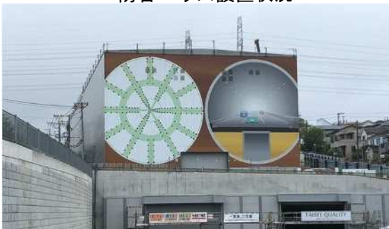
防音ハウス設置状況
