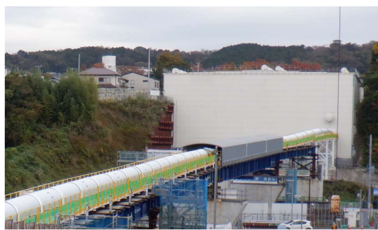
ベルトコンベア設置状況
