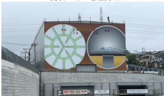
防音ハウス設置状況
