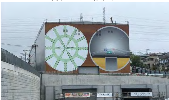
防音ハウス設置状況
