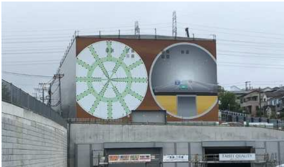
防音ハウス設置状況
