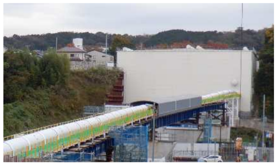
ベルトコンベア設置状況
