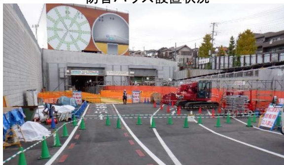
防音ハウス設置状況
