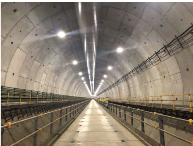
上り線坑内（R8.6撮影）
