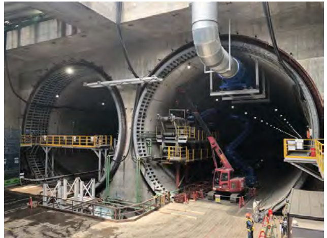
回転立坑内の状況（R8.6撮影）
