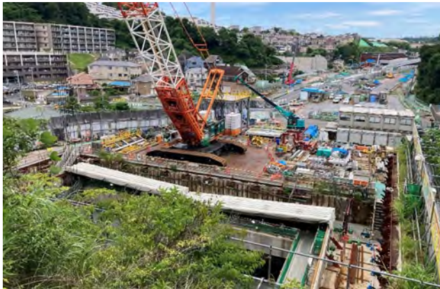
全景写真(R6.7撮影)
