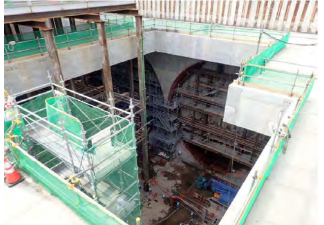
立坑内写真(R5.1.12撮影)
