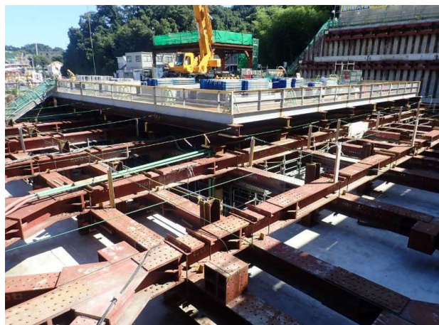
立坑内写真(R4.7.9撮影)
