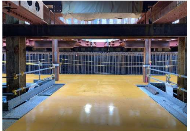
立坑内写真(R4.5.11撮影)
