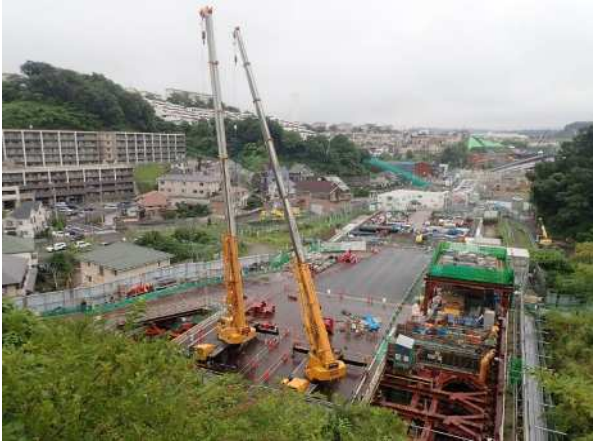
全景写真（仮橋工）
