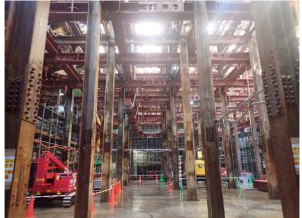
立坑内写真（底板状況）
