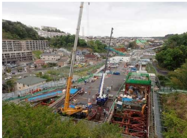
全景写真（仮栈橋工）
