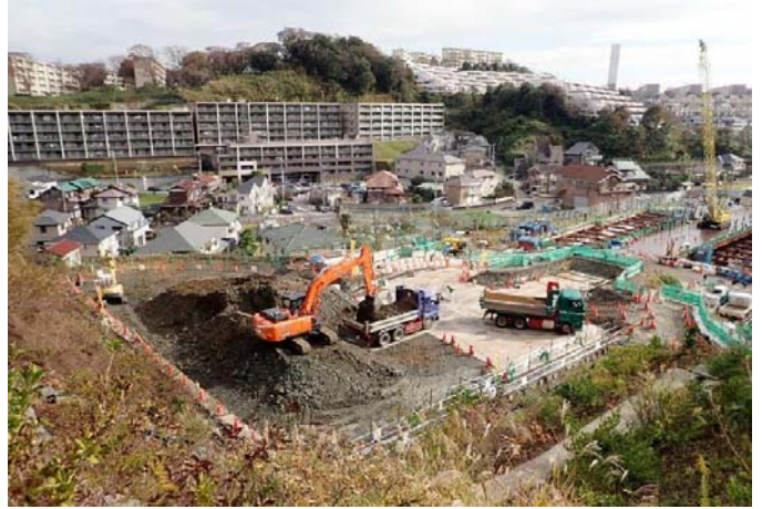
施工現場写真
