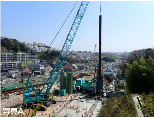
回転立坑ヤード 土留-山留工（等厚式連続壁工）
