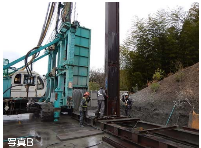
回転立坑ヤード 土留-山留工（等厚式連続壁工）
