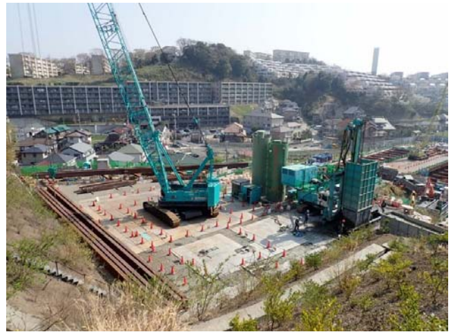
施工現場写真
