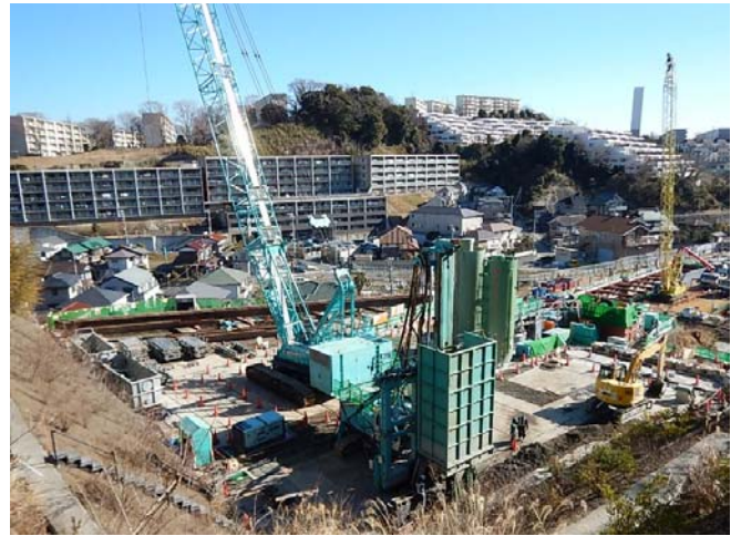
施工現場写真
