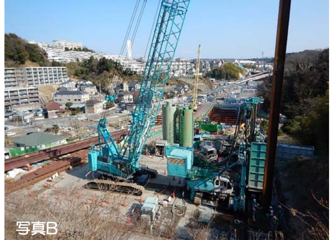
回転立坑ヤード 土留-山留工（等厚式連続壁工）
