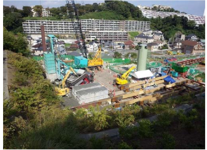
施工現場写真
