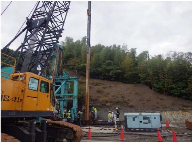
回転立坑ヤード 等厚式連続壁工 (左：写真A、右：写真B)
