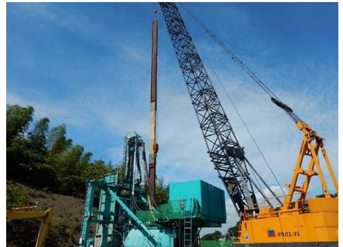
回転立坑ヤード 等厚式連続壁工 (左：写真A、右：写真B)
