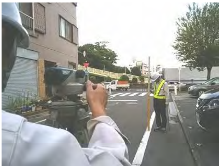
地表面沈下測定
