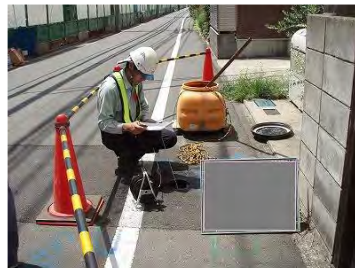
地下水位観測
