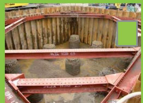
【施工イメージ写真】
