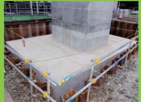
【施工イメージ写真】
