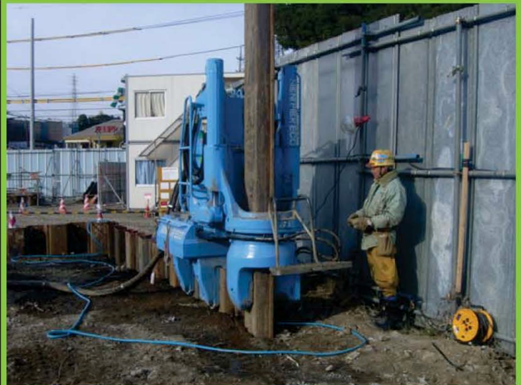
【施工イメージ写真】
