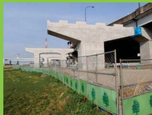
【施工イメージ写真】
