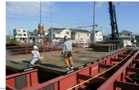
覆工板設置作業写真
