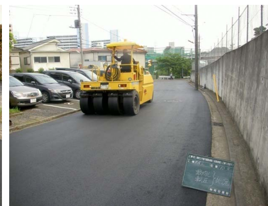
アスファルト転圧作業写真
