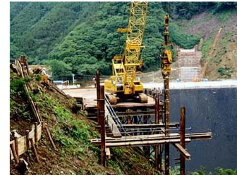
覆工板設置作業写真
