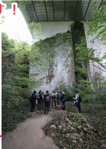
横浜横須賀道路高架橋下のピオトーブ
