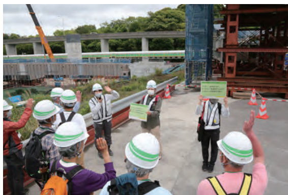
○ 釜利谷ジャンクションの鋼上工(橋梁)工事 景観配慮のため、橋桁の塗装色として周辺景観との調和・大規模構造物の圧迫感低減・季節変化の影響を受けにくいといった条件に適する色を採用しました
