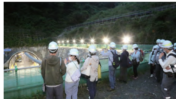
○ 釜利谷ジャンクション内の工事現場 生物生息空間の保全を目的に土地改変面積を最小限とするため、切土構造からトンネル構造に変更しました
