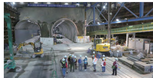
周辺住居の環境保全のため、非開削工法を採用した庄戸トンネル坑口にある防音ハウス内部を見学
