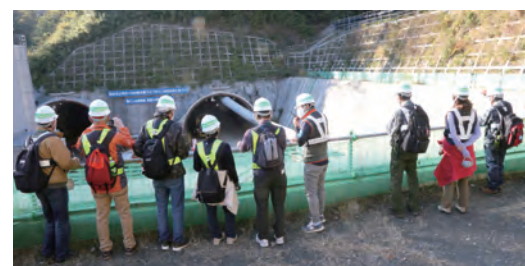
生物生息空間の保全を目的に土地改変面積を最小限とするため、切土構造からトンネル構造に変更した釜利谷ジャンクション付近を見学
