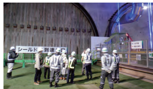
掘進の再開にあたり開催した現場見学会で、発進到達立坑内を見学(令和4年2月11日)
