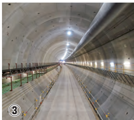
桂台トンネル上り線シールドトンネル内部
