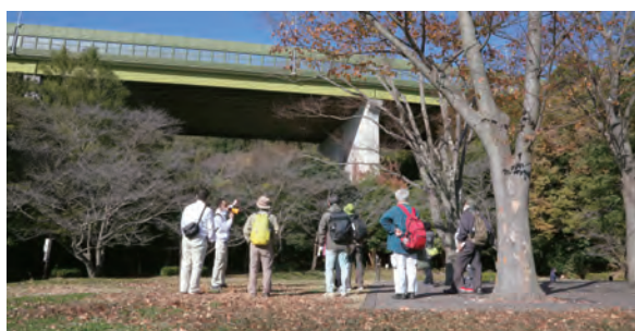
横浜横須賀道路の高架橋。景観に配慮した色で塗装されています
