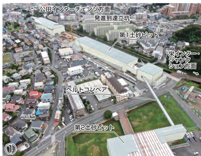
飯島地区の発進到達立坑付近。擁壁区間を利用して土砂ピットなどを設置
