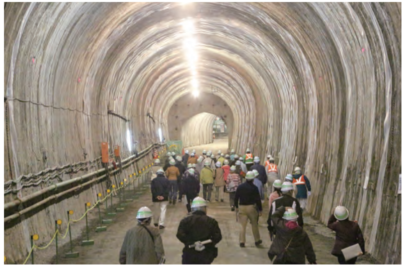
構築が完了している低土被り区間を歩いて見学
