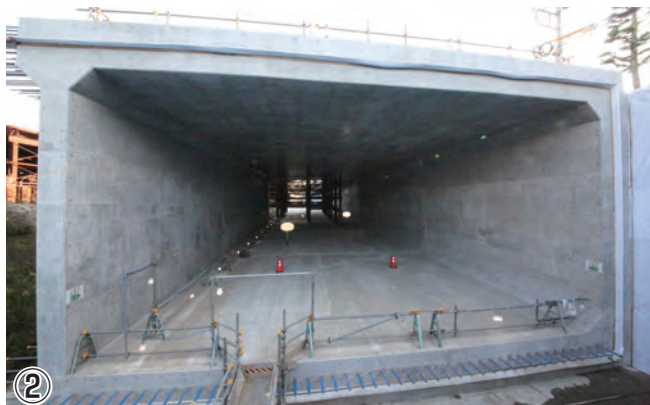
② 完成しているランプ部の函渠
