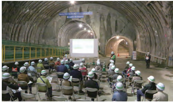
下り線の拡幅区間では、トンネルの造り方についてご紹介しました
