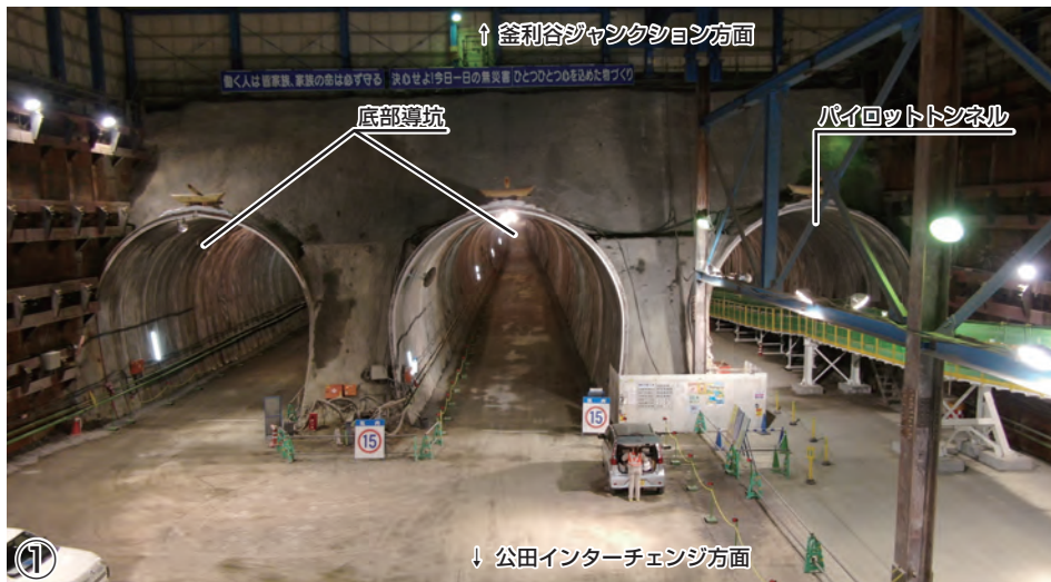
庄戸トンネル坑口防音ハウス内の状況
