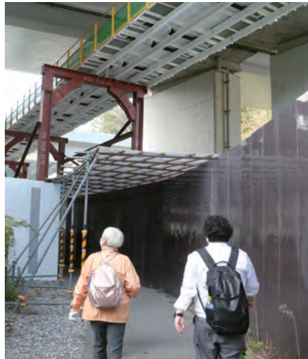
新ひょうたん池に向かう遊歩道には、 よこかんみなみ のトンネル工事で発生した土砂を運搬するための、ベルトコンベアが設置されています。トラックで運ぶ方法に比べてCO 2 排出、巻き上げ粉じん、騒音の削減効果があります
