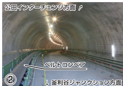
パイロットトンネル(Cランプトンネル)内の状況
