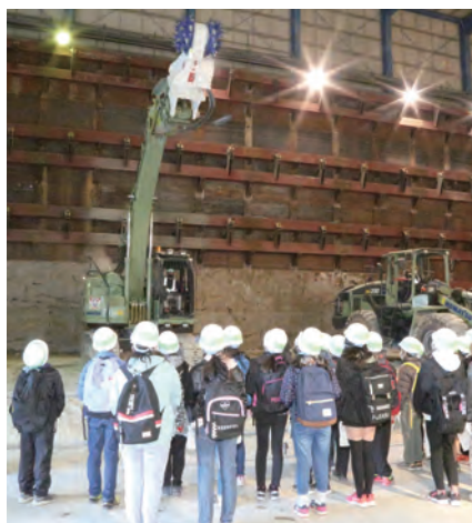
トンネルを掘削するツインヘッダーを見学
