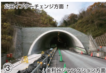
パイロットトンネル(Cランプトンネル)釜利谷側坑口の状況
