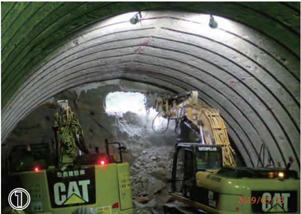
釜利谷東トンネル下り線貫通(坑内から)
