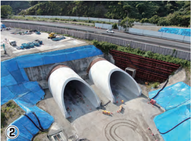
釜利谷東トンネル東側坑口 ※横浜環状南線のインターチェンジ・ジャンクション・換気所・トンネルなどの名称は、釜利谷ジャンクション以外はすべて仮称です
