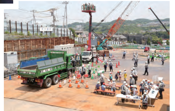
▲高所作業車やダンプトラックに乗るなど、工事現場を体験
