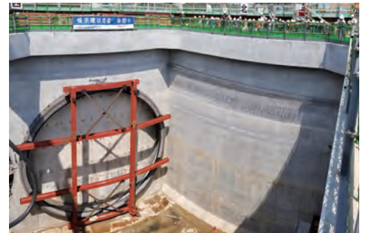
▲シールドマシンを入れる立坑を上からのぞいて見学
