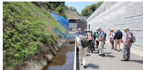
▲釜利谷ジャンクションの工事現場脇に新しく設置された水路で、今後、整備を進める予定です
