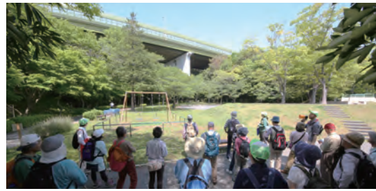
▲横浜横須賀道路の景観に配慮した色で塗装された橋梁
