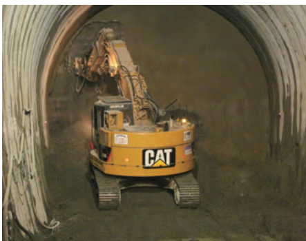
▲ 掘削のようす
