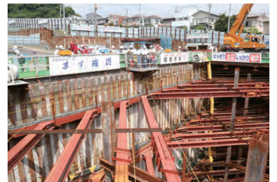
▲工事現場を上からのぞいて見学
