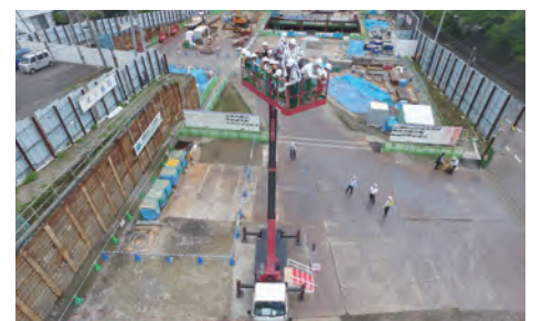
▲高所作業車に乗って工事現場を上から見学
