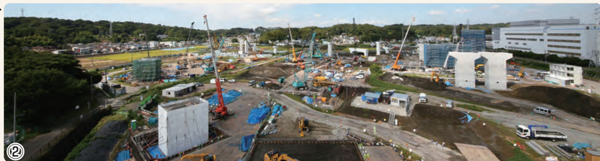
▲公田笠間トンネル工事 シールドマシンを発進及び到達させる立坑を掘る準備をしています
