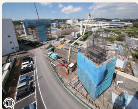
▲横浜南栄IC・JCT下部工事(写真①～②) インター・ジャンクション内の橋梁の橋脚の施工を行っています
