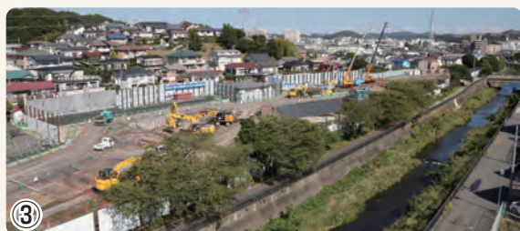
▲公田笠間トンネル工事 シールドマシンを発進及び到達させる立坑を掘る準備をしています
