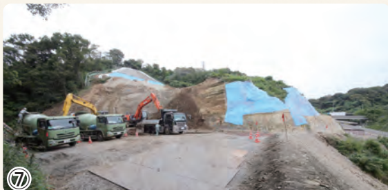
▲釜利谷ジャンクション工事 釜利谷トンネル付近の切土工事を行っています
