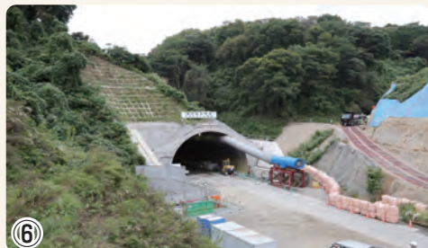
▲釜利谷ジャンクションCランプトンネル工事 釜利谷ジャンクション側からトンネルを掘っています
