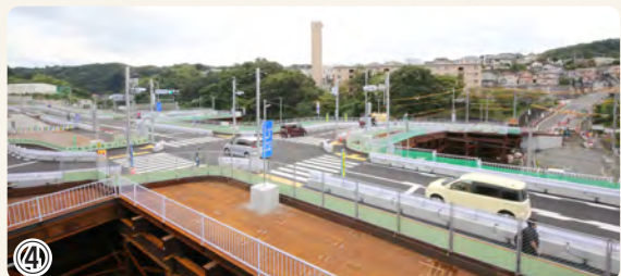
▲公田地区掘削試験工事 迂回道路(仮橋道)へ交通を切り替えました
