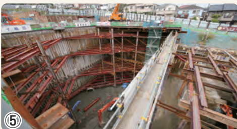
▲桂台トンネル工事 シールドマシンを発進及び到達させる立坑の掘削を行っています
