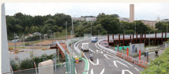
▲仮橋道の通行が始まりました。注意してご通行ください
