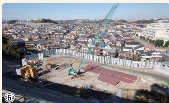
▲ 回転立坑を掘削するための土留壁を施工しています
