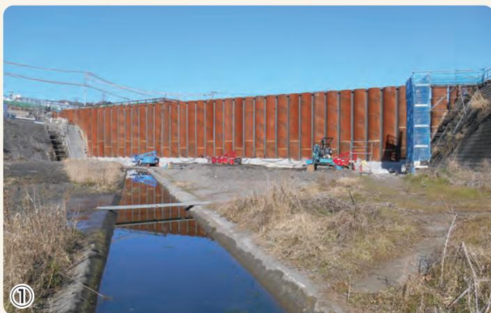
▲ 土工部の調整池内にできた鋼管杭の壁
