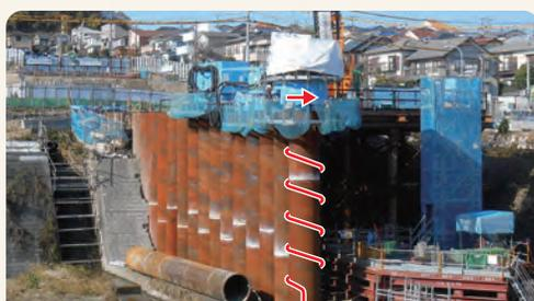
▲ 鋼管杭の施工中。鋼管の先端にビット(歯)がついていて、回転させながら圧力をかけ、鋼管を継ぎ足しながら、地中深くまで建て込みます
