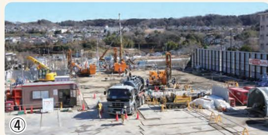
▲ 掘削する部分の地下水の止水対策を行っています
