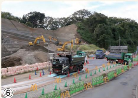
⑥ 桂台トンネル工事 シールドマシンが回転する立坑を施工するため、切土を行っています
