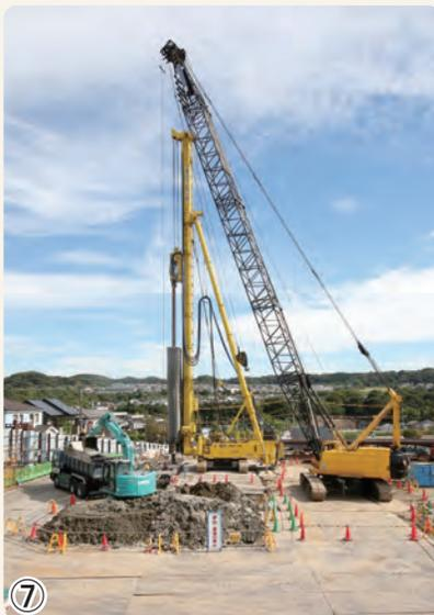
⑦ 桂台トンネル工事 シールドマシンを発進及び到達させる立坑の土留杭を施工しています
