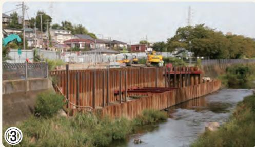
③ 飯島地区河川閉塞工事 いたち川旧河道部の護岸の施工を行っています
