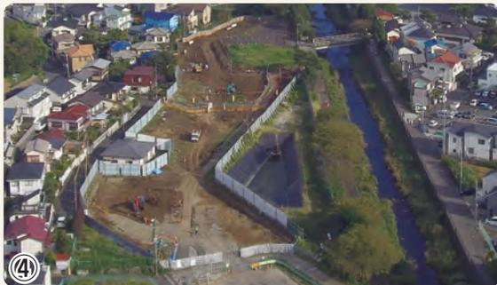
④ 公田笠間トンネル工事 シールドマシンを発進及び到達させる立坑を掘る準備をしています
