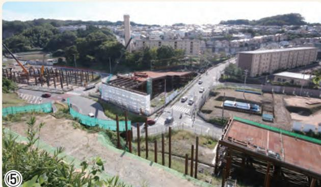
⑤ 公田地区掘削試験工事 掘削部を掘削するため、現道を迂回させる仮設の橋をつくっています
