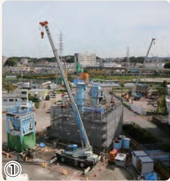
① 横環南栄IC・JCT下部工事(写真①~②) インター・ジャンクション内の橋梁の橋脚の施工を行っています
